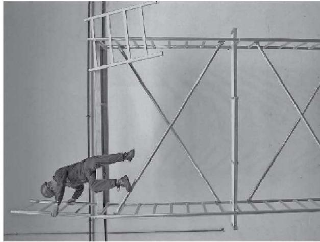
**Ostrożnie wstać** ( ponieważ nie zamontowano jeszcze zabezpieczeń bocznych). Zamontować jednometrowe ramy pionowe i zabezpieczyć łączenia zawleczkami.
