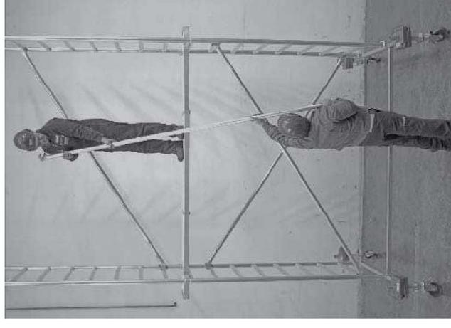
**Wskazówka:** Do montażu i demontażu przewidziane są pomosty pomocnicze. Po zakończeniu montażu i demontażu należy je usunąć. Według normy DIN4420-1 deski muszą mieć szerokość nie mniejszą niż 24 cm a grubość przynajmniej 4,5 cm. Do zamocowania pomostu deski muszą być dłuższe od rusztowania o przynajmniej 20 cm z każdej strony.
