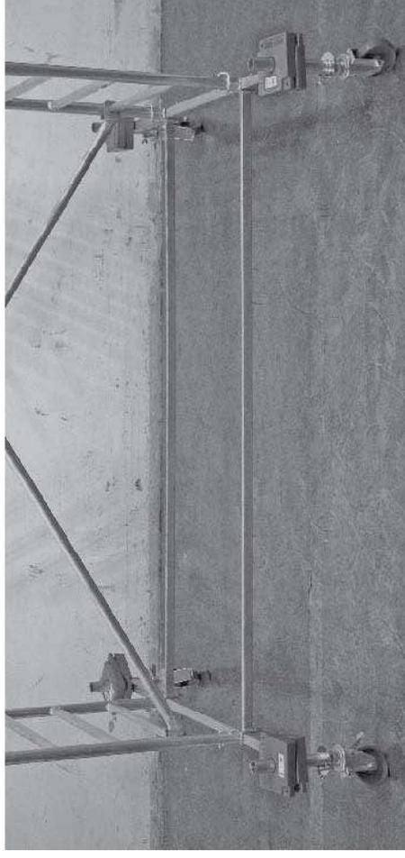
**Ważne:** Przed dalszym montażem należy koniecznie obciążyć rusztowanie ciężarkami balastowymi, w zależności od wariantu, według tabeli balastowania, strona 28 - 31.
